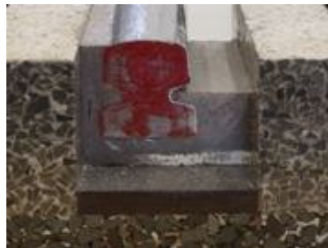
Figuur 2 Trillingsreductie door isolatie rond de spoorstaaf
